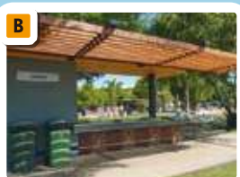
屋根、ゴミ箱、水道がセットのBBQ台。
